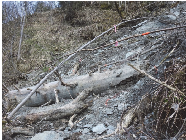
Abb. 11: Die Trasse des zu errichtenden Pirschsteiges muss für den Errichter klar und gut ersichtlich markiert werden. Jagdliche Notwendigkeit geht vor leichterem/billigerer Errichtung.
