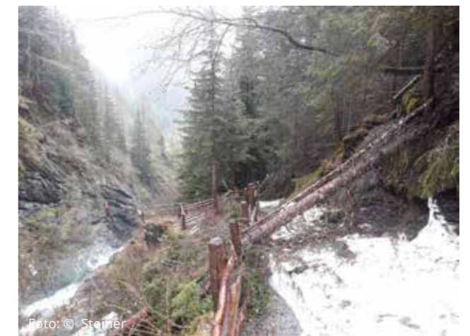
Foto: © Steiner Der „Wasser-Kraft-Weg“ entlang der Umbalfälle, Prägraten a. G. musste ebenfalls saniert werden. Das Freischneiden der umgestürzten Bäume aufgrund der Schneelast und die Wiederherstellung der teils abgesetzten Wegführung forderten die Einsatzkräfte.
