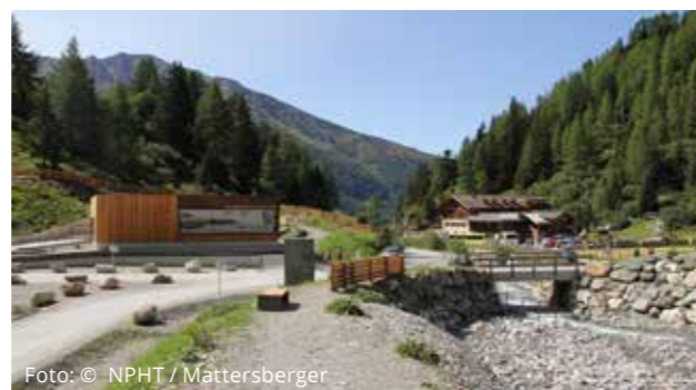
Foto: © NPHT / Mättersberger Auch auf eine geregelte Infrastruktur (Parkplatz, Müll, WC-Anlagen) bei den Eingängen zum Nationalpark Hohe Tauern wird großer Wert gelegt. Hier bei der Ausstellung Glocknerwinkel im Kaiser Ködnitztal.
