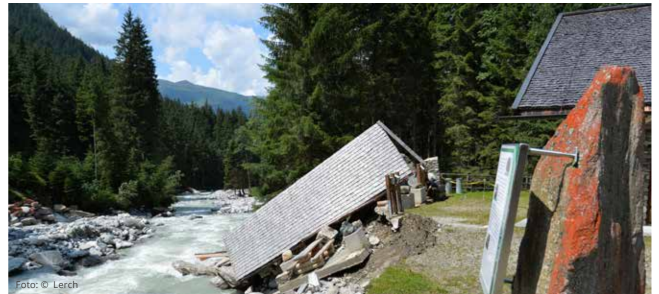
Foto: © Lerch Die Schauhütte am Gelehrweg im Untersulzbachtal, Neukirchen a. G., wurde aufgrund der Starkniederschläge unterspült und weggerissen.
